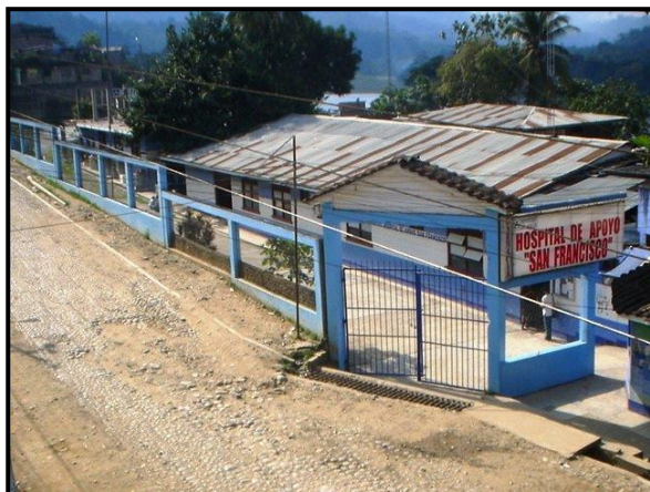
Fig. 1. Hospital de Apoyo “San Francisco”–VRAEM – Perú.
